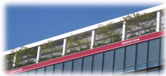
開発施設の壁面（屋上）緑化状況（駅前）
