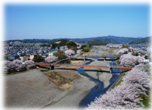
下流側よりふれあい大橋を望む
