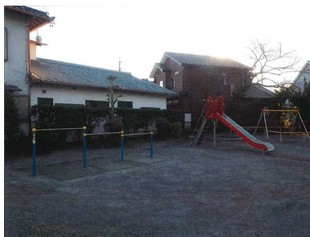
藤岡第5公園（完成）
