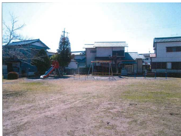
藤岡第2公園（完成）
