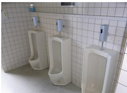
※着手前（ウエット方式）
