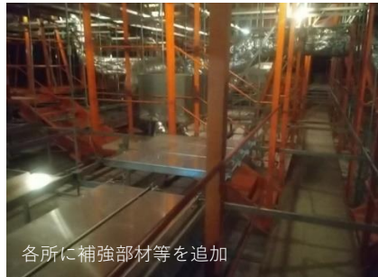
※完成（大ホール天井裏）
