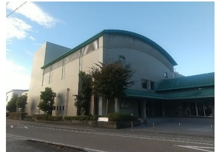
※完成（外部防水改修）
