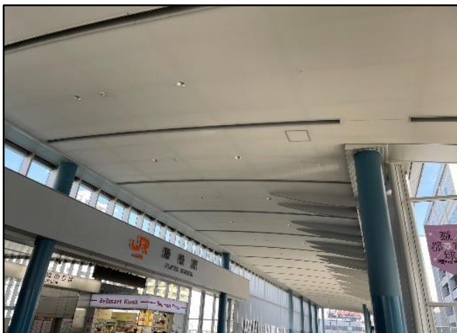
※着手前（北口側から撮影）
