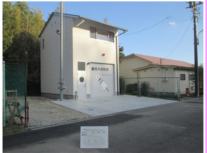
第11分団3班（内谷） 施工：(株)森下工務店
