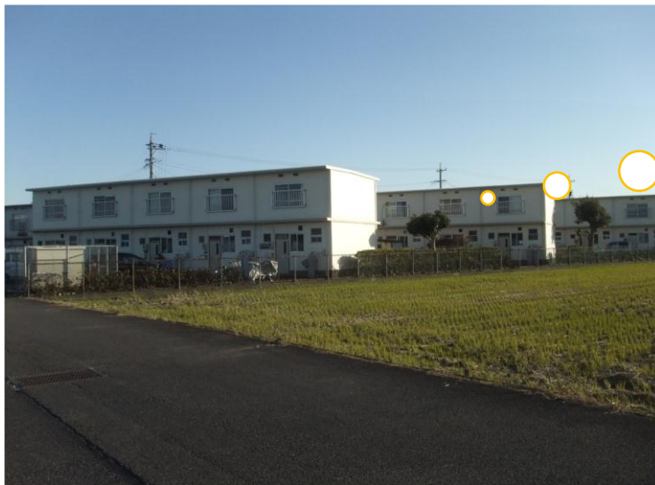
大洲西団地（3期）屋上・外壁防水改修工事
