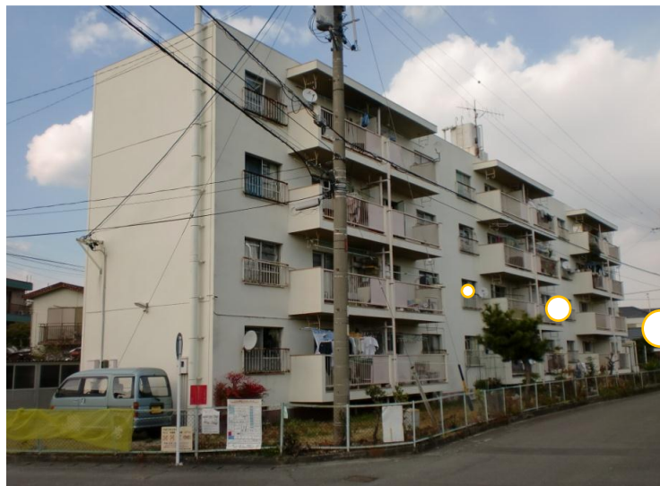
藤枝一丁目団地屋上・外壁防水改修工事
