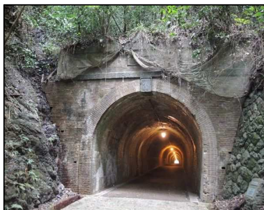
写真 2 レンガ積（明治トンネル）
