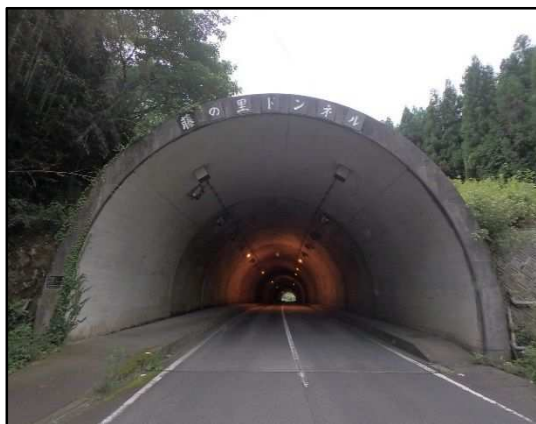
写真 1 NATM（藤の里トンネル）
