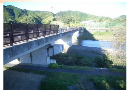
堀之内高架橋・運動公園大橋（堀之内）
