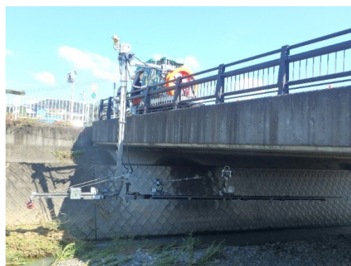
写真 新技術による点検状況
