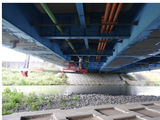
写真 橋梁点検車による点検状況 （久市橋）
