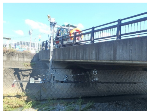
写真 新技術による点検状況
