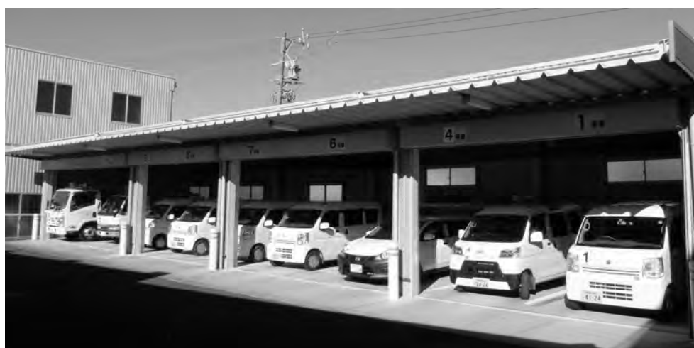
△ 茶町水道資材倉庫・車庫
