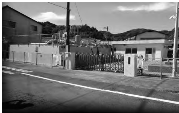
△ 西北ポンプ場
