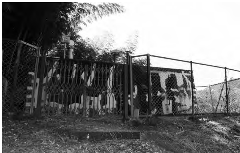
△ 朝比奈中央配水場
