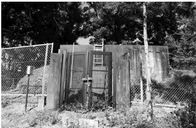
△ 殿西ノ平配水場
