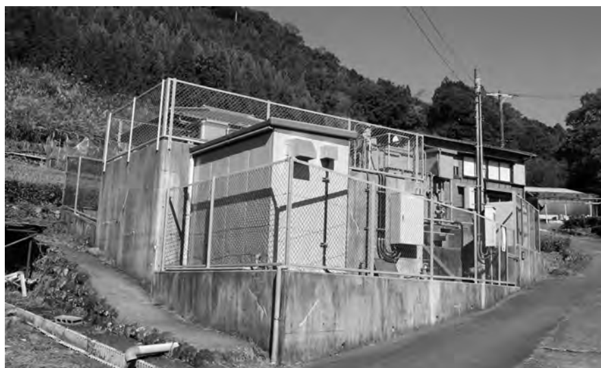
△ 青羽根配水場
