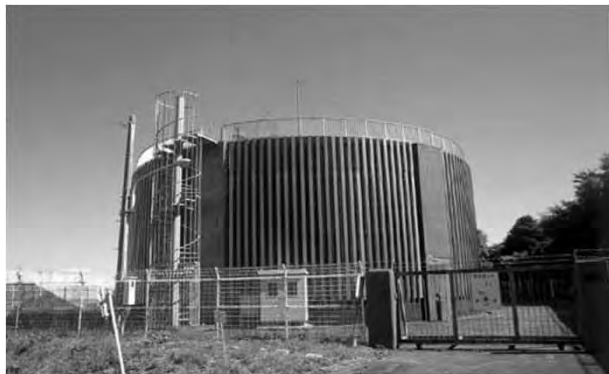
△ 内瀬戸第2配水場
