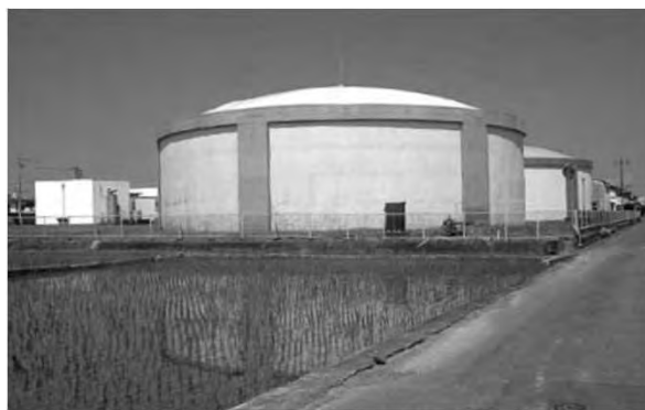
△ 泉町配水場配水池
