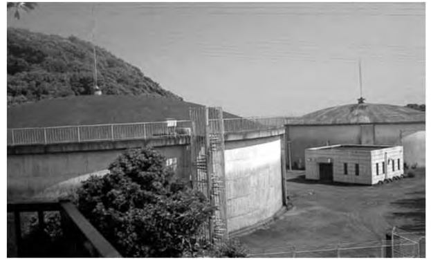
△ 内瀬戸第1配水場
