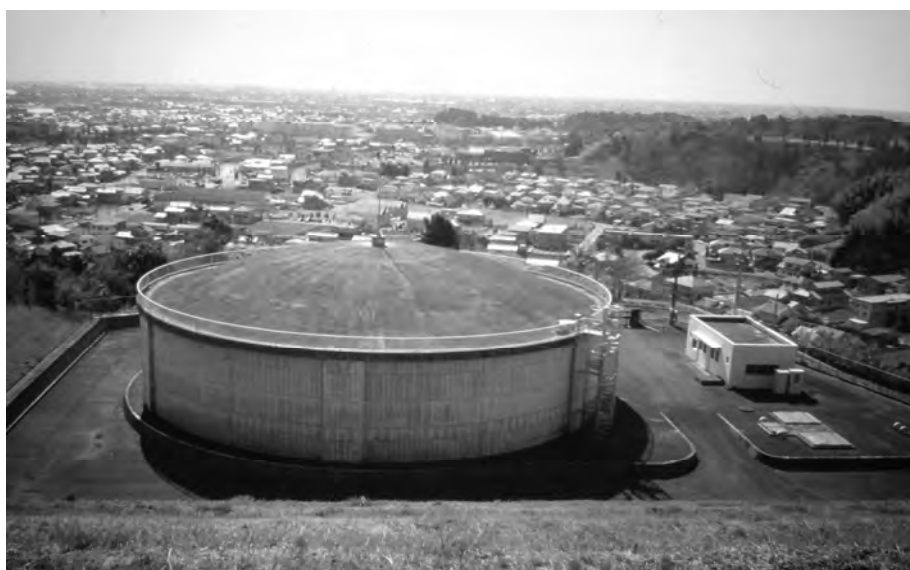
△ 時ヶ谷配水場
