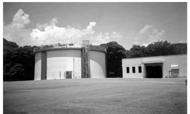
△ 内瀬戸第3配水場
