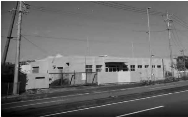
△ 青南町送水場・資材倉庫
