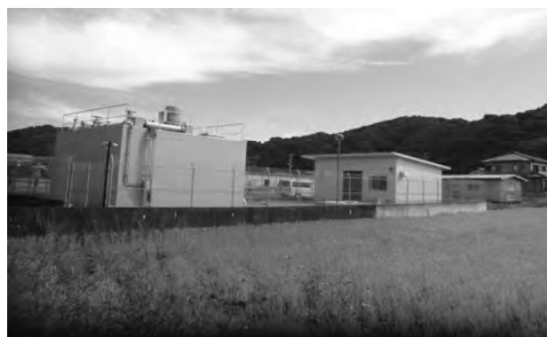
△ 新村良送水場
