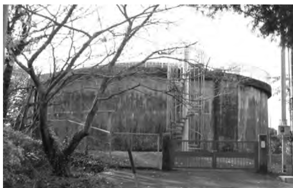
△ 子持坂配水場
