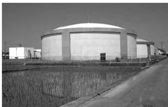
△ 泉町配水場配水池
