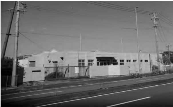
△ 青南町送水場・資材倉庫
