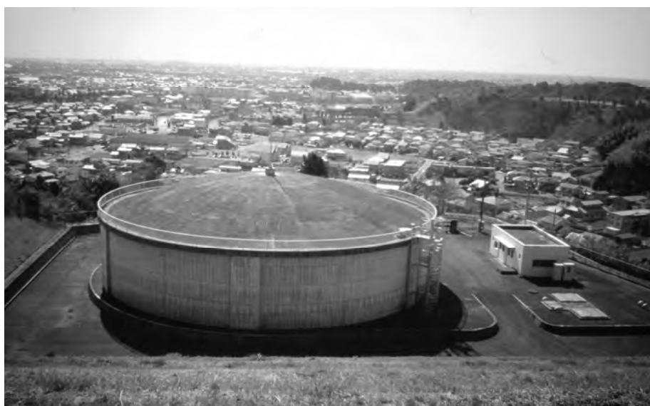
△ 時ヶ谷配水場
