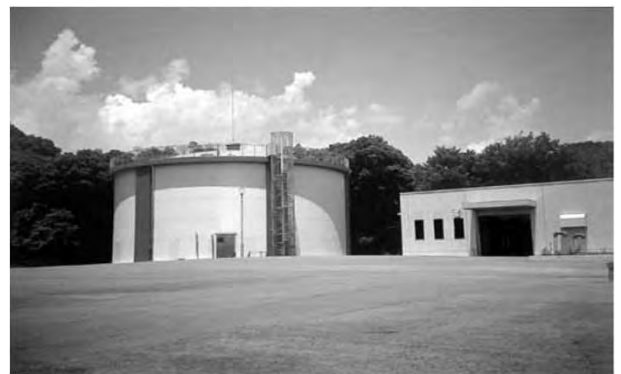
△ 内瀬戸第3配水場
