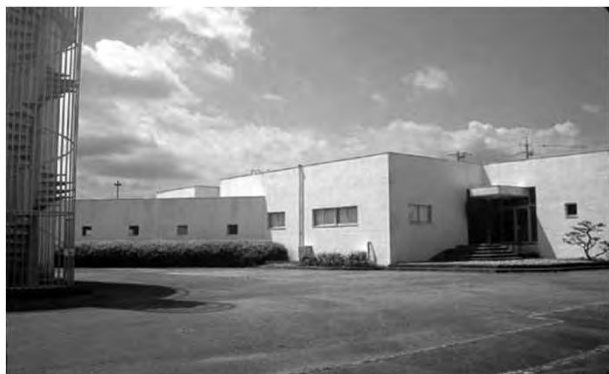
△ 泉町配水場管理棟
