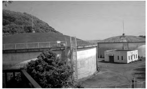
△ 内瀬戸第1配水場
