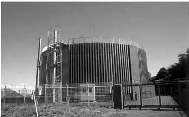
△ 内瀬戸第2配水場
