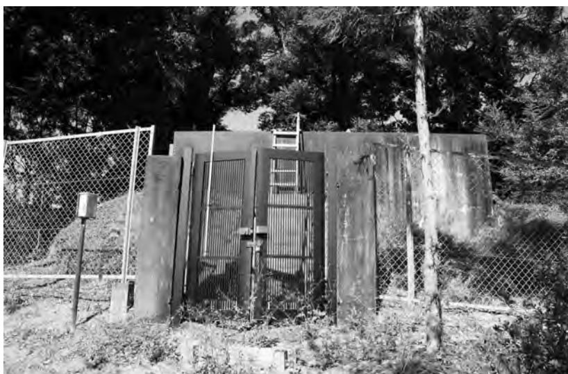
△ 殿西ノ平配水場
