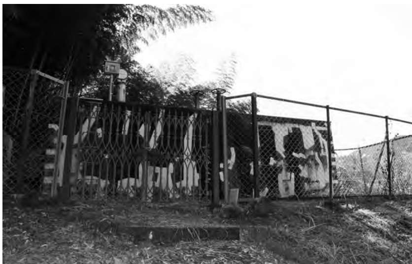
△ 朝比奈中央配水場
