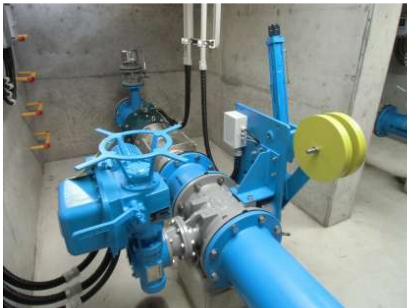
志太配水場 緊急遮断弁
