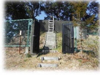
殿西ノ平簡易水道
