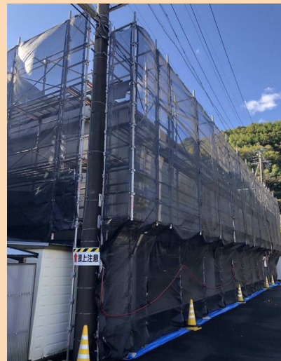
車庫棟（倉庫）の仮設状況
