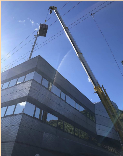
クレーンでの資材搬入
