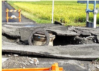
下水管マンホール破損
