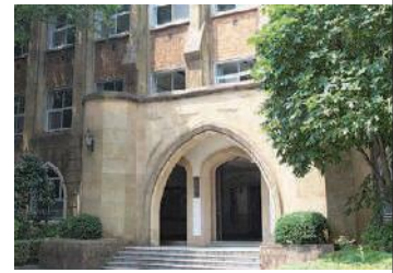
学習院大学西一号館
