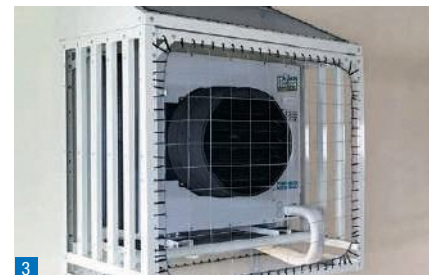
3 コンクリート壁に壁掛け設置
