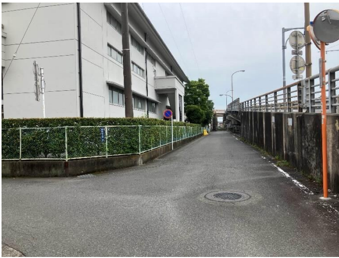
＜市民体育館裏＞ タクシーなどがスピードを出してよく通る。歩道と車道の区別がなく逃げ場もない。
