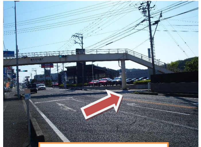
＜内瀬戸歩道橋下＞ 一旦停止しない車や自転車と歩行者がぶつかりそうになる。
