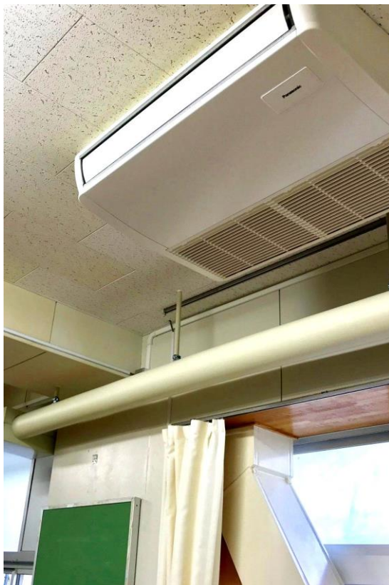
小学校洋式化トイレ／空調設備
