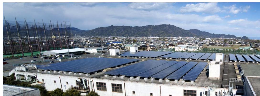
河川護岸の草刈り／屋根を活用した太陽光発電
