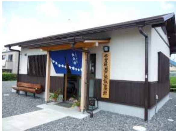
千貫堤・瀬戸染飯伝承館
