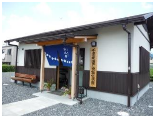
千貫堤・瀬戸染飯伝承館
