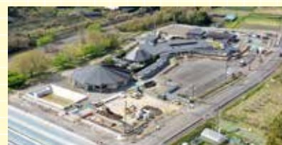
建設中の新陶芸センターと道の駅 （藤枝市本郷）
