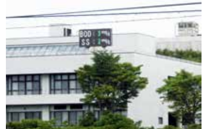
浄化センター
