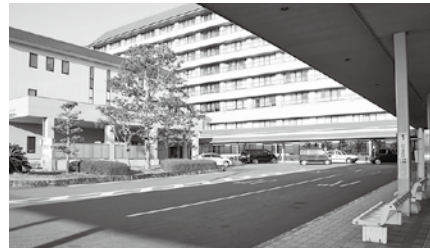
藤枝市立総合病院（厨房は地下1階にある）
