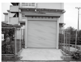
高洲南小学校校内 防災倉庫
