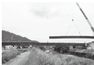
葉梨川と法ノ川に架かる三輪立花線新橋
