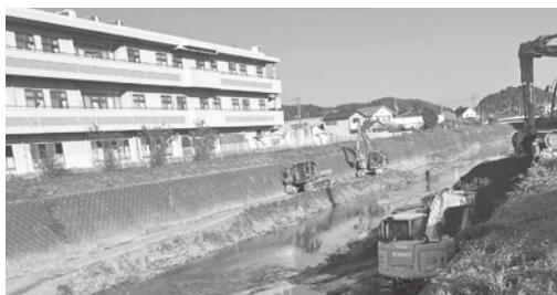
2級河川 しんげつ の浚渫
