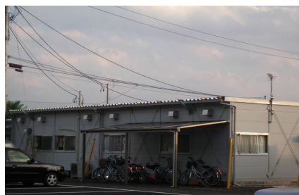
浪江町仮設住宅（岳下住民センター）64戸中58戸入居
