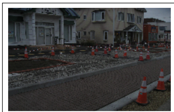
恵庭市内(道路整備工事現場)
