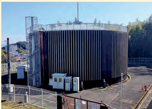
内瀬戸第2配水場
