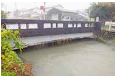
令和元年台風第19号 (萬蔵橋)
