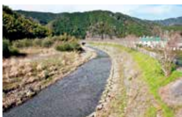
改修が必要な朝比奈川・殿前川原
