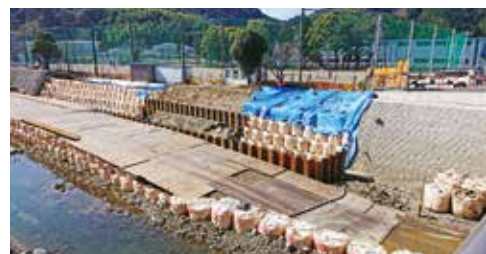
葉梨川井尻堰の河川工事
