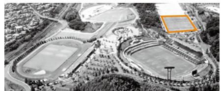
総合運動公園人工芝グラウンド設置予定地
