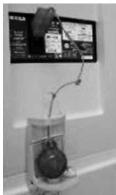
通電火災を防ぐ簡易型感震ブレーカーの一例
