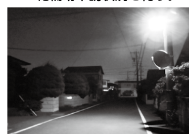
夜道を明るく照らすLED防犯灯
