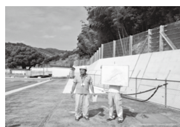
稲葉小学校の擁壁工事完了現場
