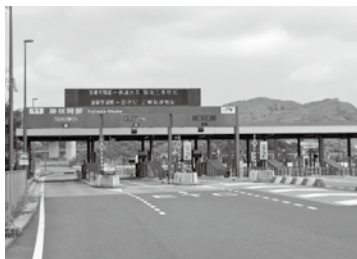
藤枝岡部インターチェンジ付近
