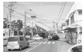
瀬戸踏切付近の状況
