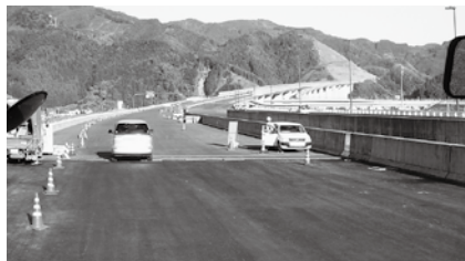
建設中の新東名高速道路
