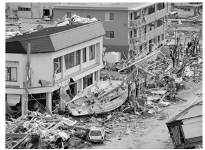
東日本大震災による津波被害
