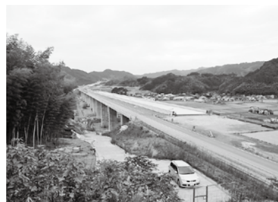
建設中の新東名高速道路
