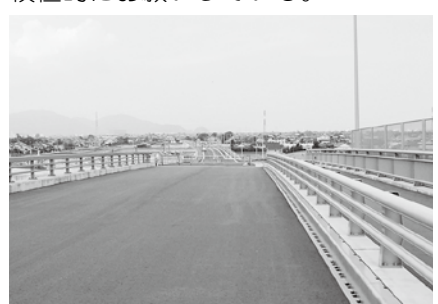
大井川新橋からみる志太中央幹線
