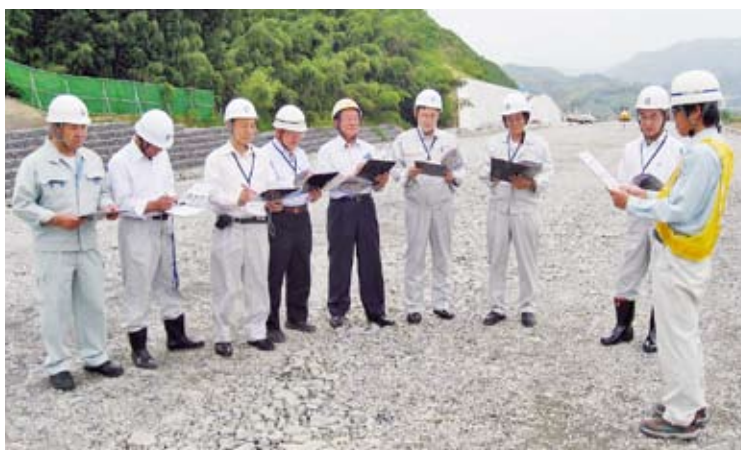
文教建設経済委員会 現地調査(新東名アクセス道路高田建設現場)
