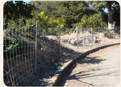
▲金網柵設置の事例
