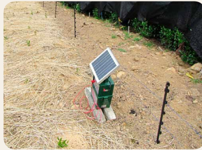
▲電気柵設置の事例
