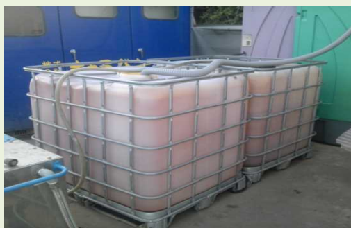
散水用 雨水貯蔵タンク
