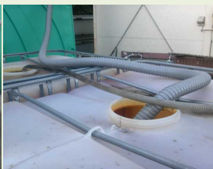
散水用 雨水貯蔵タンク
