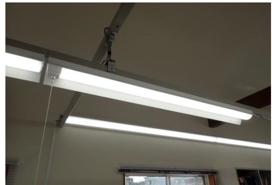
各照明器具へのプルスイッチの取付 省電力型照明器具への取替え
