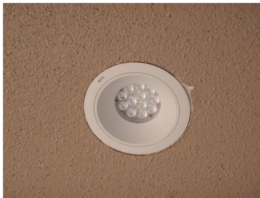
事務所外部照明のLED化
