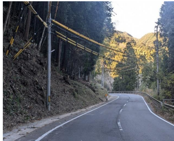
（支障木伐採実施後）
