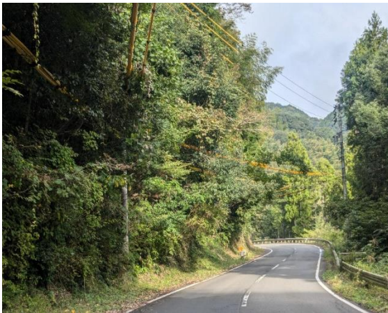
（支障木伐採実施前）
