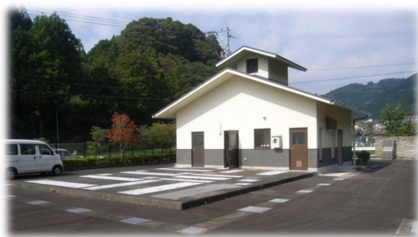
農業集落排水処理施設（市之瀬処理場）
