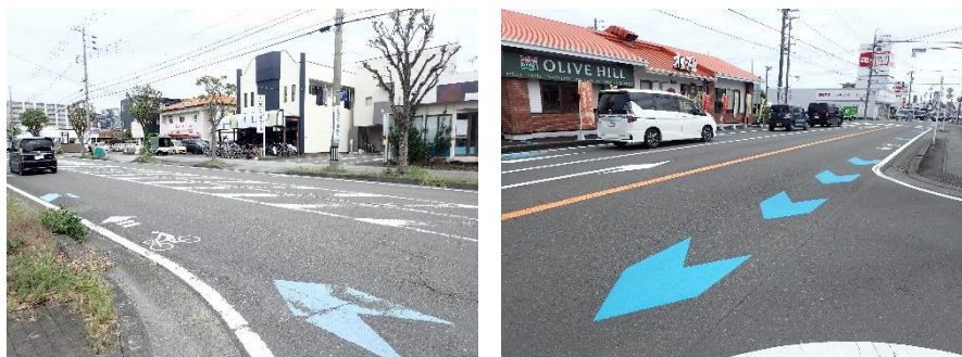
図表 3-17: 自転車通行空間整備(混在型:矢羽根整備) (藤枝市)
