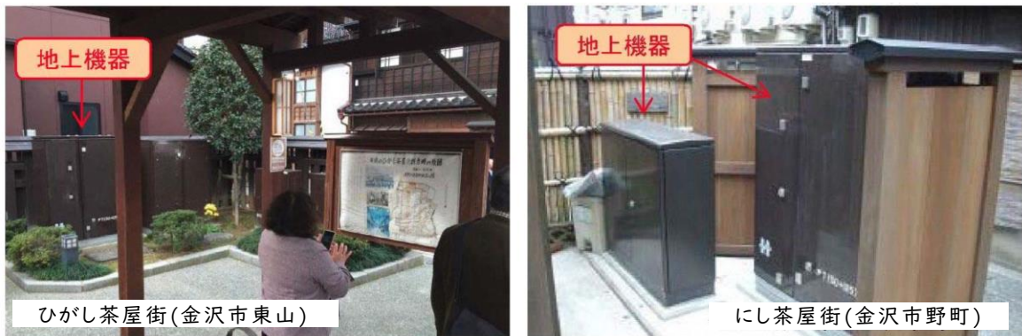
図 5-11：道路区域外における地上機器の設置事例
