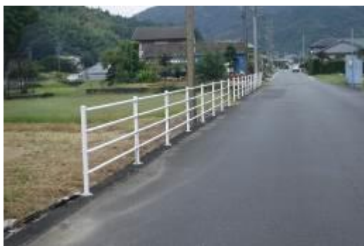
車両用防護柵が設置された道路
