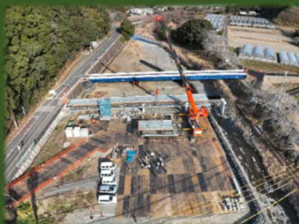
主桁架設状況
