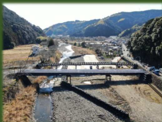
仮橋設置完了
